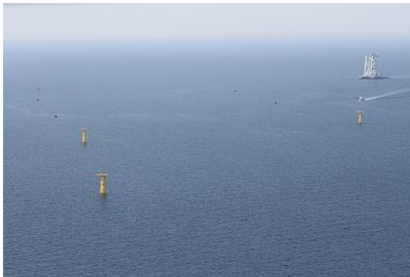
Offshore-Windpark Butendiek in der Bauphase. Foto ITAW
