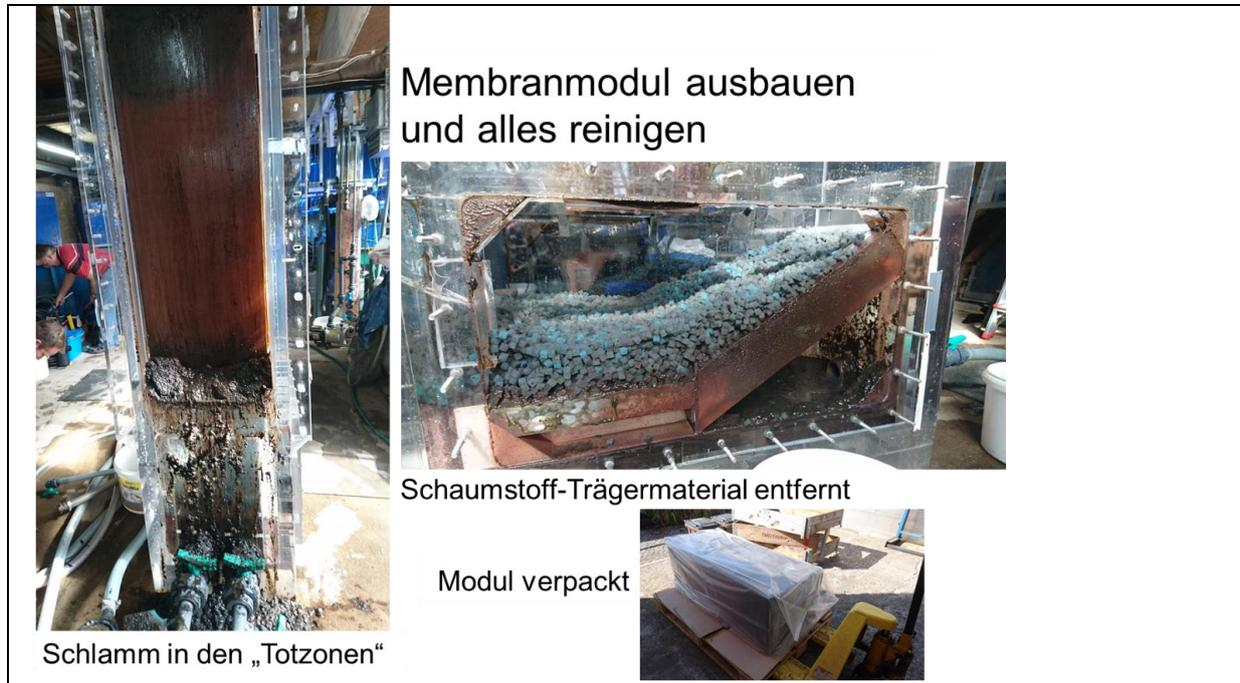
Abb. 57: Am 16. d Ausbau und Verpacken des Membran-Moduls und Entfernung des Schaumstoff-Trägermaterials (OST1).
