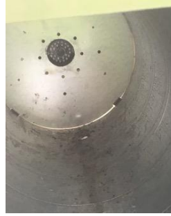
Abbildung 4 Rohrfalle mit Kamera
