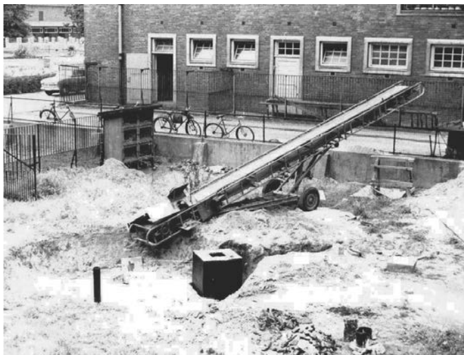
Abb. 43: Bau von einem der drei großen Becken zum Abklingen von Radioaktivität (1968).
